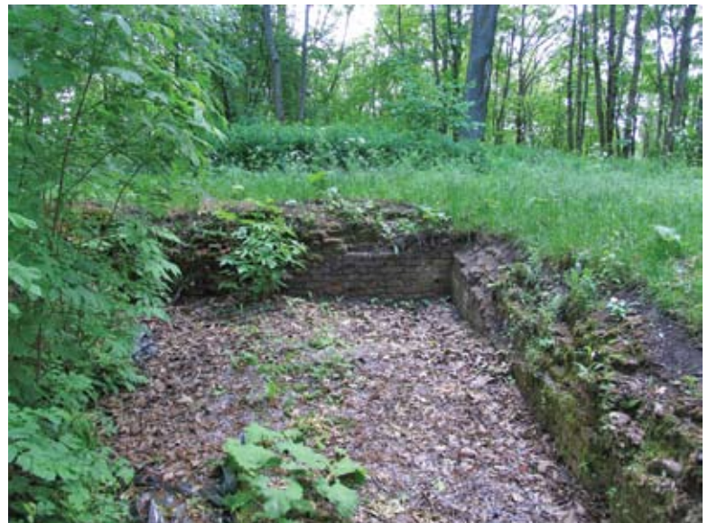
4. Фундамент Швейцарского домика на Ореховой горе. Фото Н.Н. Воробьева, 21 июня 2008 г.
